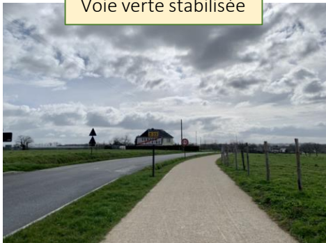
Voie verte stabilisée
