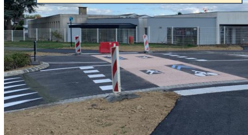
Traversée cyclable rue
