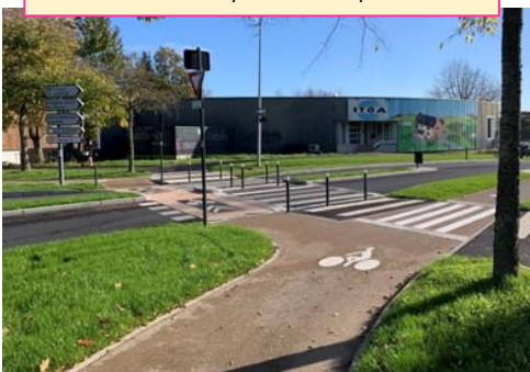
Traversée cyclable et piéton
