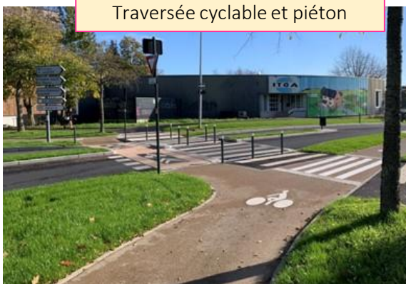
Traversée cyclable et piéton
