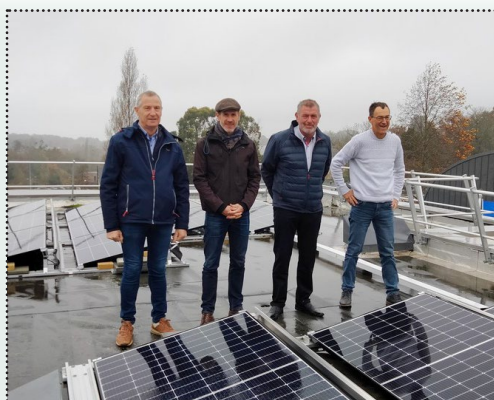
Mise en service des panneaux photovoltaïques sur la toiture du siège d'Arc Sud Bretagne.
