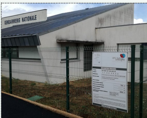
Rénovation énergétique des logements de la gendarmerie, à Nivillac
