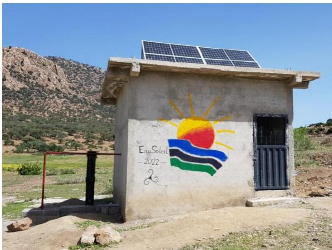
*Modules solaires sur le local technique avec à gauche la tête de forage et la tuyauterie de refoulement de la pompe – village d'Amarouch*
