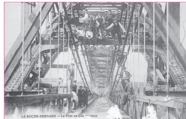
L'arc est terminé. La passerelle n'a pas encore été démolie. Les ouvriers posent pour la photo.
